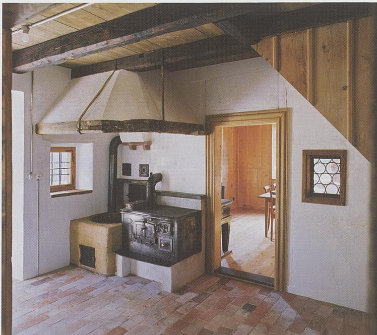
Rauchfang. Vom ursprünglichen Tonplattenboden waren Reste erhalten. Sie wurden mit gleichformatigem Material aus dem Bauteildepot der Denkmalpflege ergänzt. Von hier aus steigt die verschaltete Treppe zum Dachraum, der als Kaldach unausgebaut über der Küche liegt.
